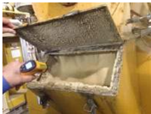
Foto 2. El empleo de medidores laser de la temperatura debe hacerse no solo en las harinas previo a la entrada en matriz sino también en el gránulo a la salida de la prensa
